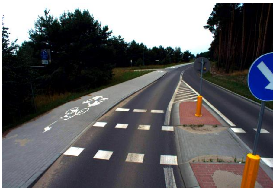
Zmiana strony jezdni ścieżki rowerowej na ul. Mosińskiej (zdjęcie: Lehmann+Partner Polska)
