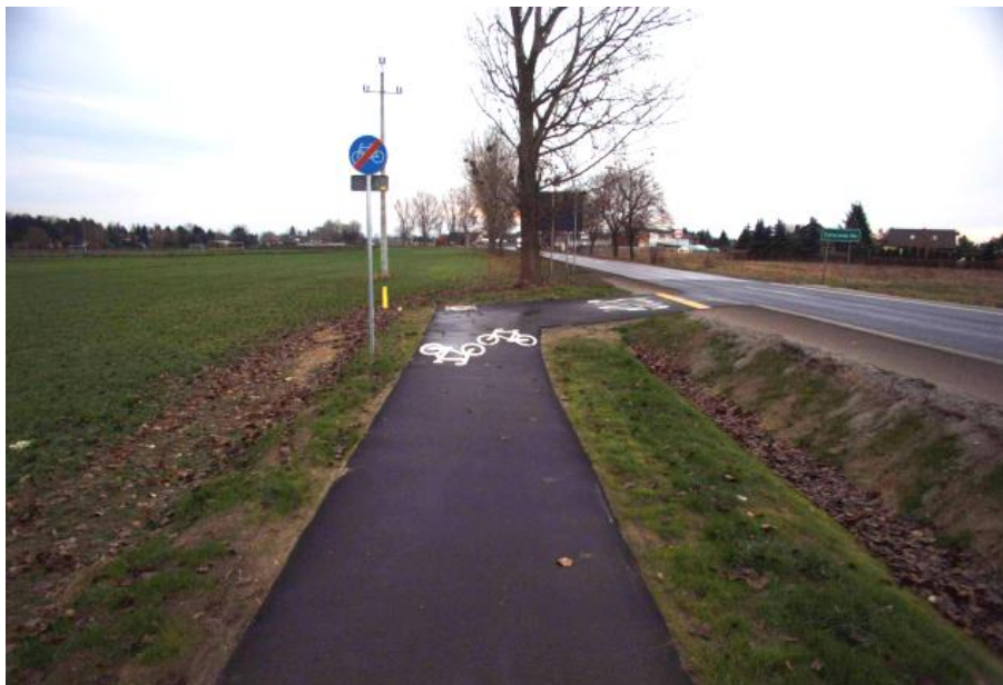
Ścieżka rowerowa wzdłuż ul. Bolesławy Prusak (zdjęcie: Lehmann+Partner Polska)
