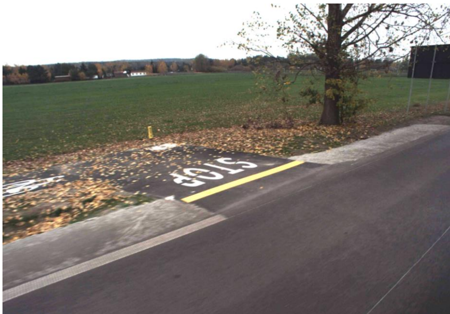
Wjazd na jezdnię istniejącej drogi rowerowej w Dymaczewie Nowym (zdjęcie: Lehmann+Partner Polska)
