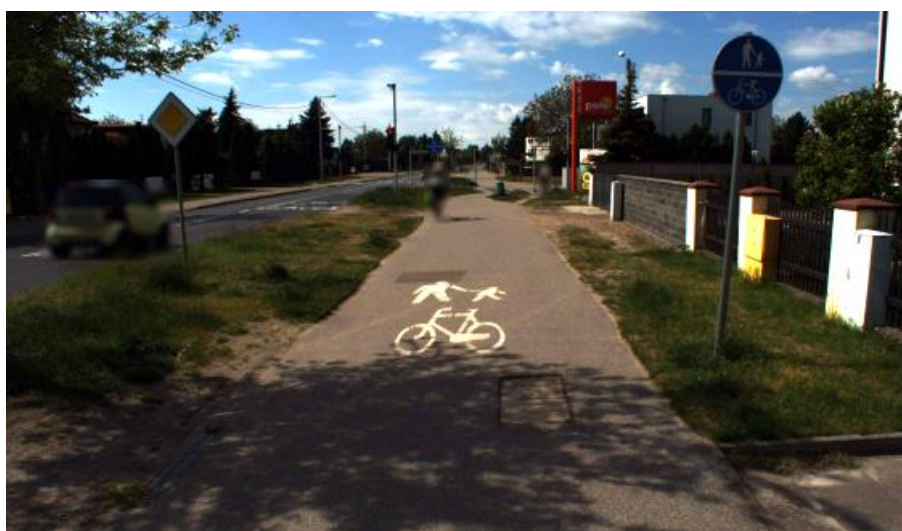
Ścieżka rowerowa na odcinku ul. Leszczyńskiej w Mosinie (zdjęcie: Lehmann+Partner Polska)
