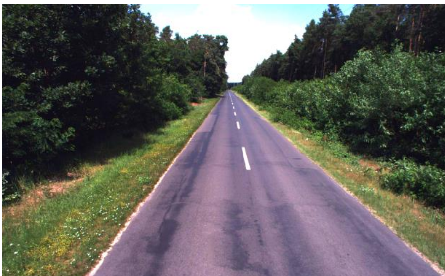
Odcinek drogi powiatowej pomiędzy Rogalinkiem, a Wiórkiem (zdjęcie: Lehmann+Partner Polska)
