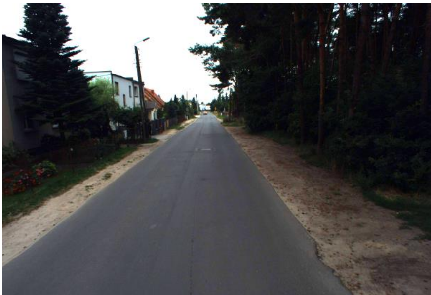
Widok na ul. Krosińską – możliwość poprowadzenia po prawej stronie jezdni ścieżki rowerowej (zdjęcie: Lehmann+Partner Polska)
