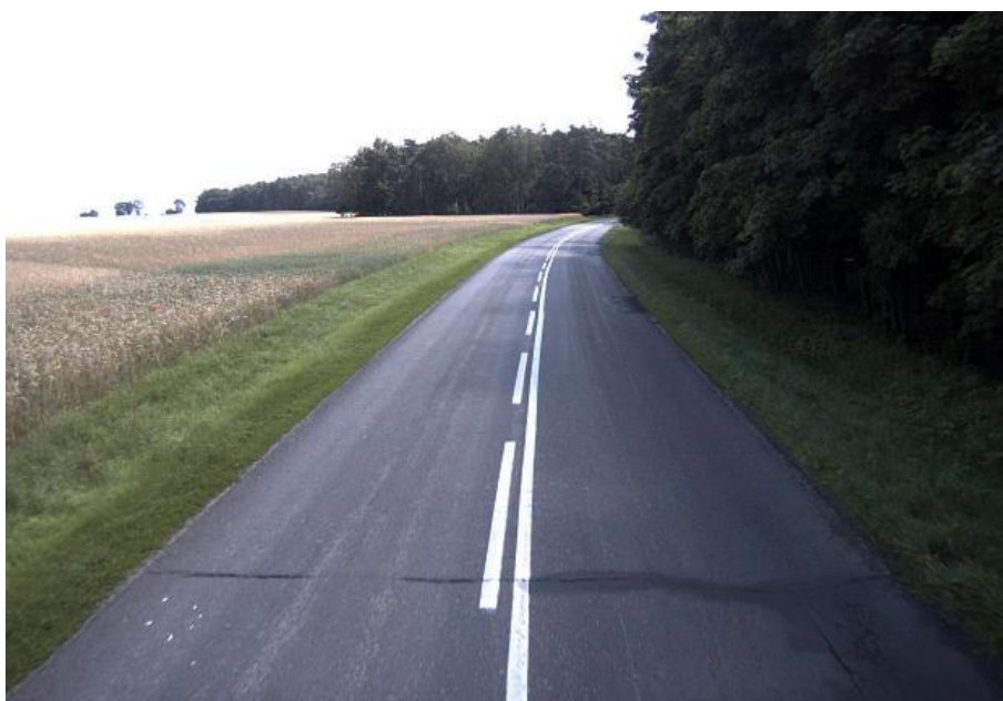
Odcinek drogi wojewódzkiej pomiędzy Świątnikami, a Mieczewem (zdjęcie: Lehmann+Partner Polska)
