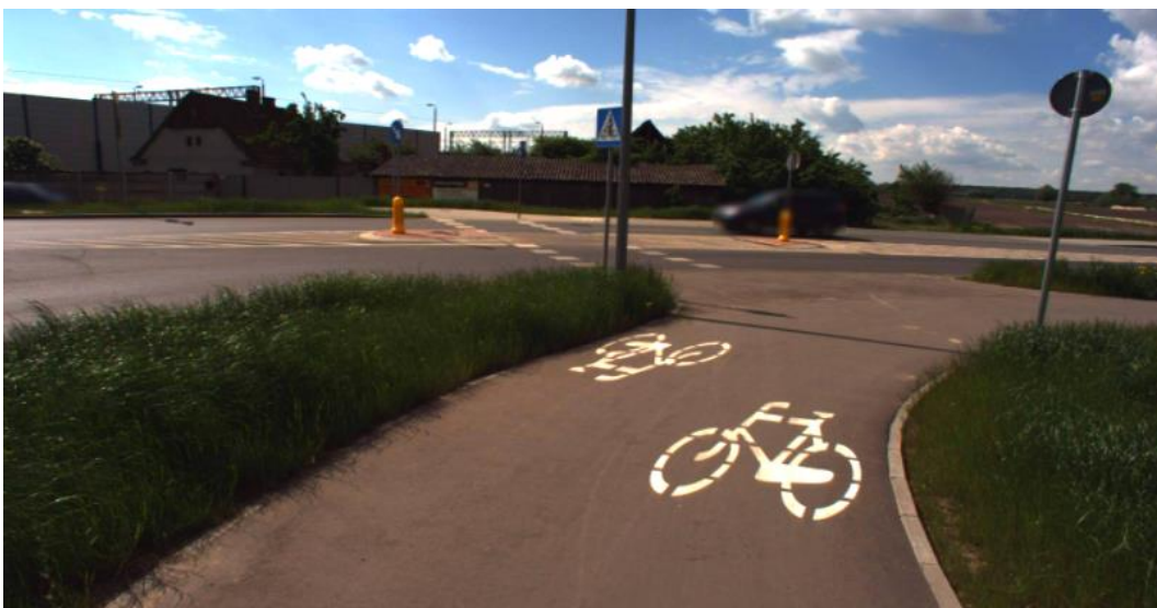
Droga rowerowa o nawierzchni asfaltowej – ul. Główna w Krośnie (zdjęcie: Lehmann+Partner Polska)
